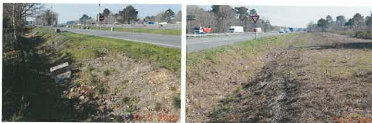
Fossé le long de la bretelle de sortie de l'Aire vers Bordeaux.>SO Fossé bordant la plateforme de l'A63 en face de l'étang de Pinoche.>NE
