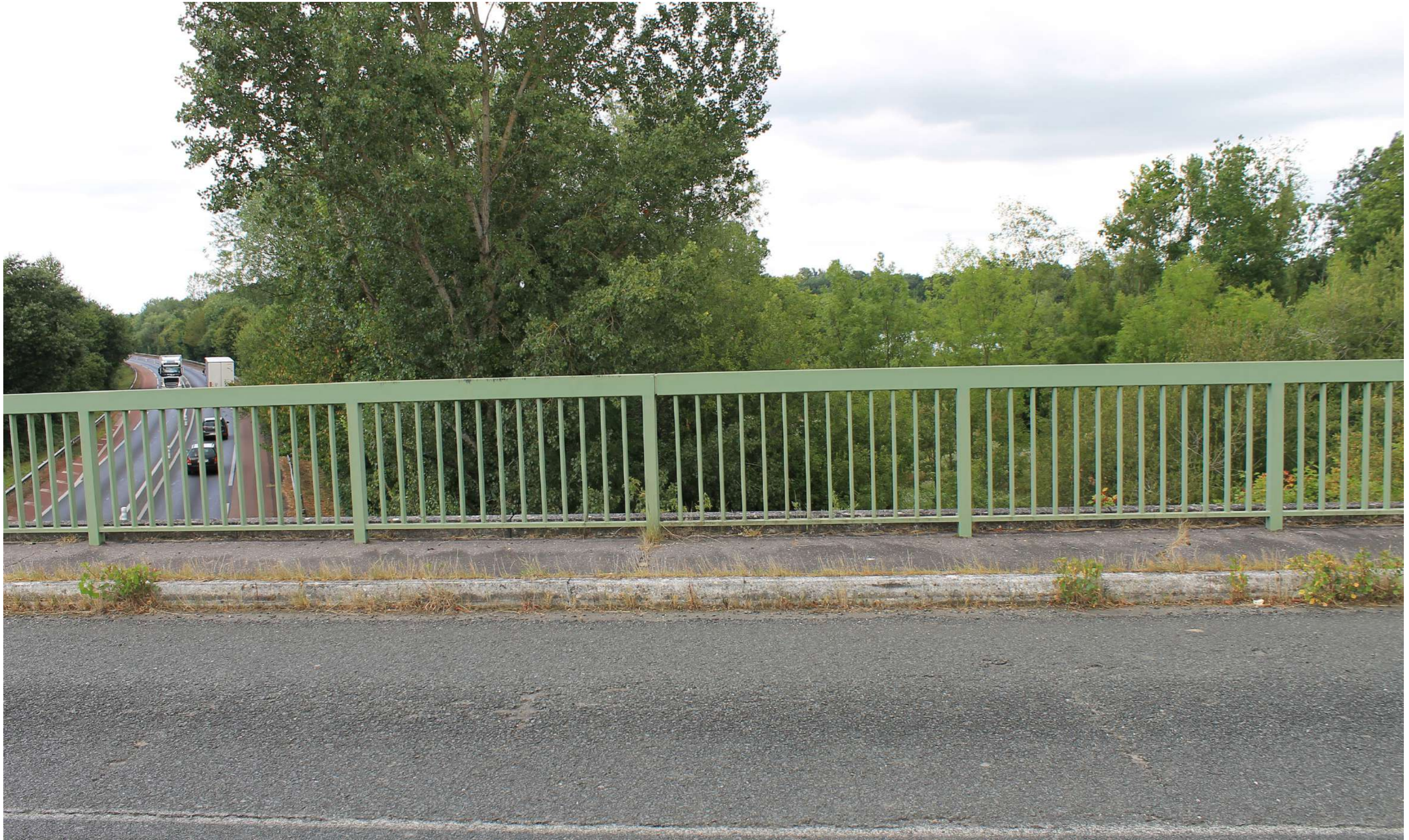
PV6 - Point de vue lointain du site depuis le pont marquant l'intersection entre la D1089 et la D128E3
