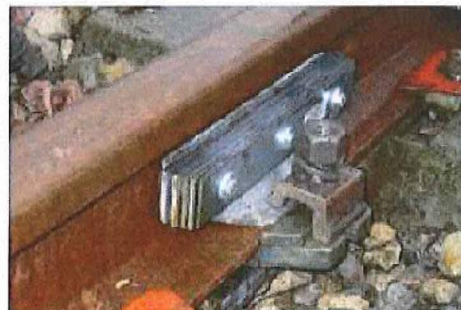
Exemples d'absorbeurs sur rail (Corus et Socitec)
