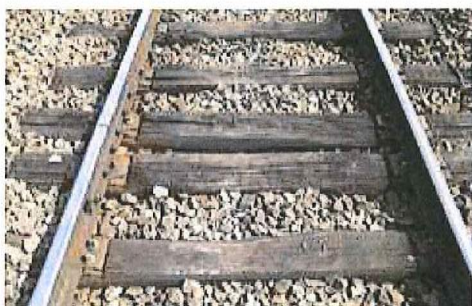
Rails courts sur traverses bois
