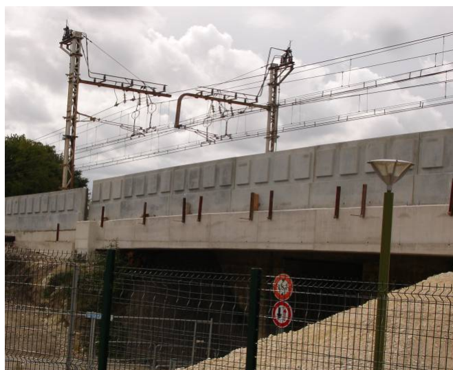
Réalisation mur anti-bruit Lormont
