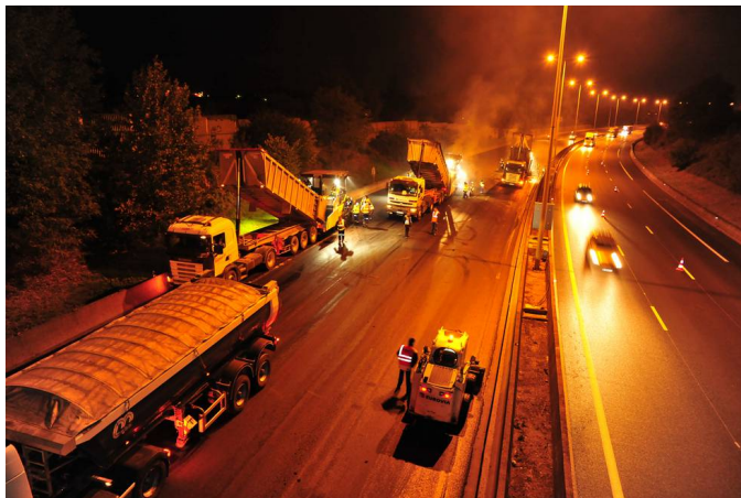
Chantier de réfection de l'A10 à 2 × 3 voies (réalisé de nuit)
