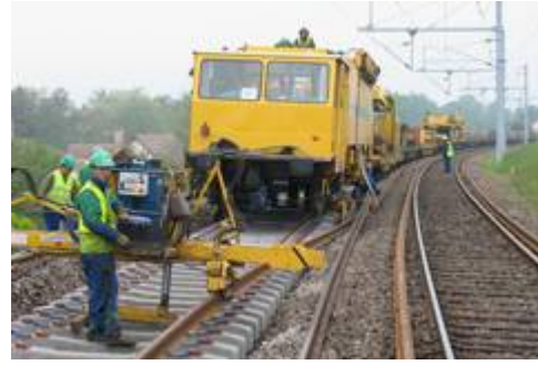
Longs Rails soudés sur traverses béton
