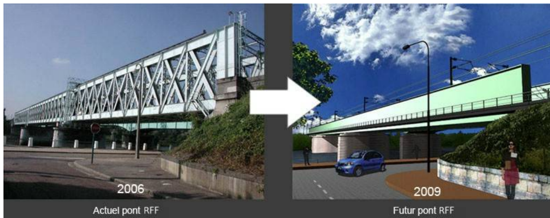
Exemple de changement de pont métallique à Oissel (76)
