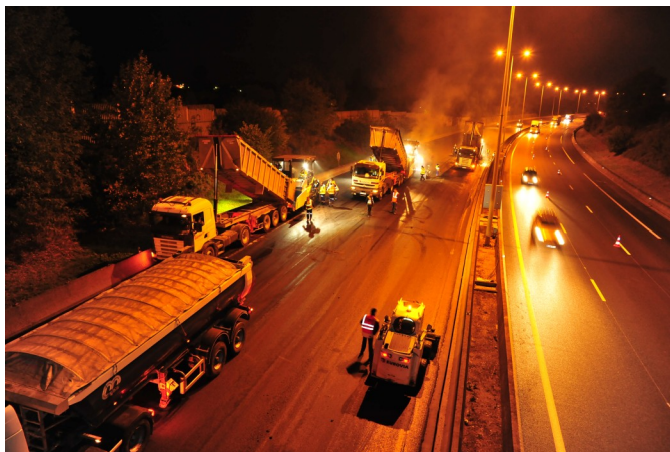
Chantier de réfection de l'A10 à 2 x 3 voies (réalisé de nuit)
