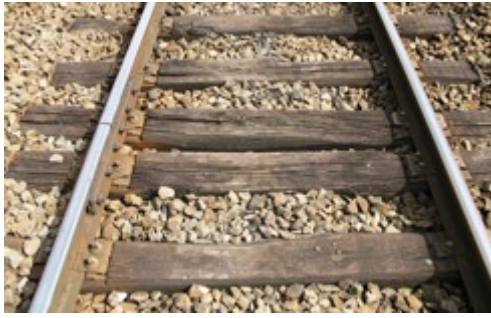
Rails courts sur traverses bois
