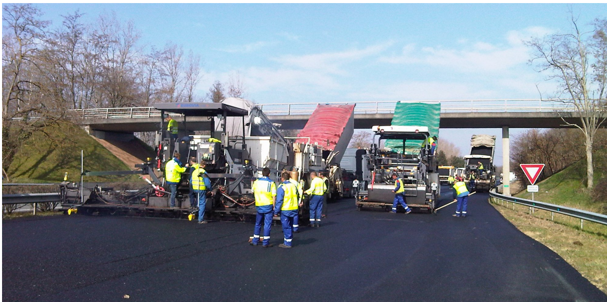
Photo du chantier de réfection de la couche de roulement d'A62
