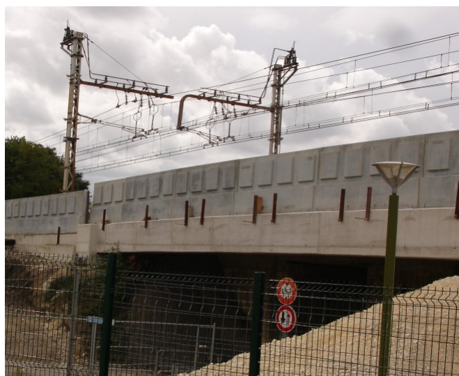
Réalisation mur anti-bruit Lormont
