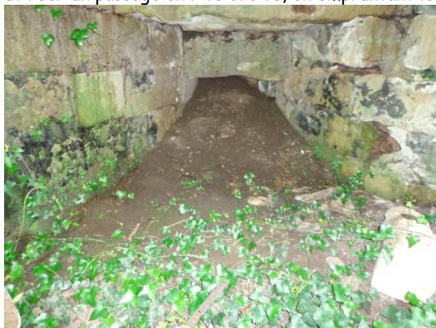
Passage inférieur depuis l'amont
