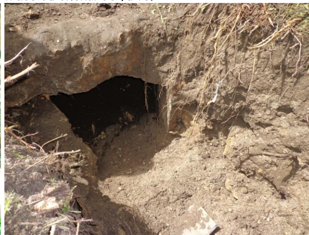
Exutoire sur la chambre remblayée
