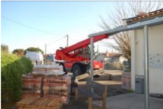
Travaux d'isolation et de couverture
