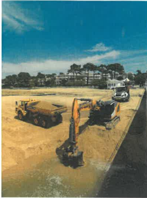
Les travaux de réensablement. © Léa Guedj/Reporterre
