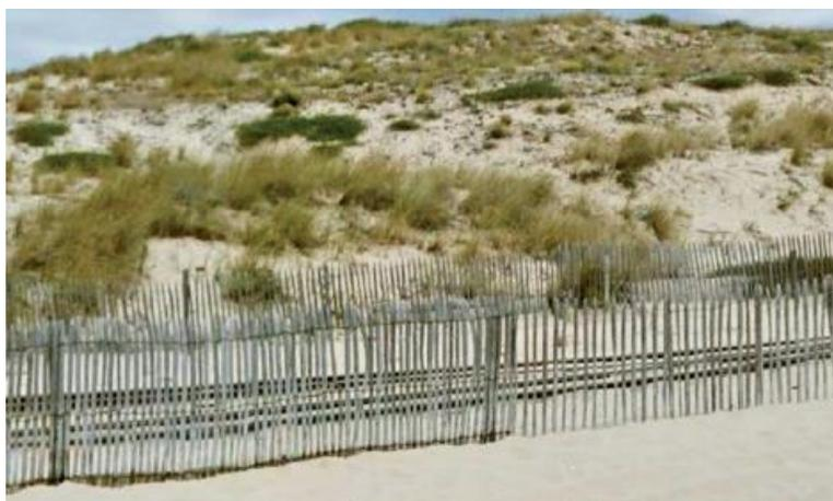
Figure 20 : Exemple de brise-vent en ganivelle sur les abords de la plage de l'horizon
