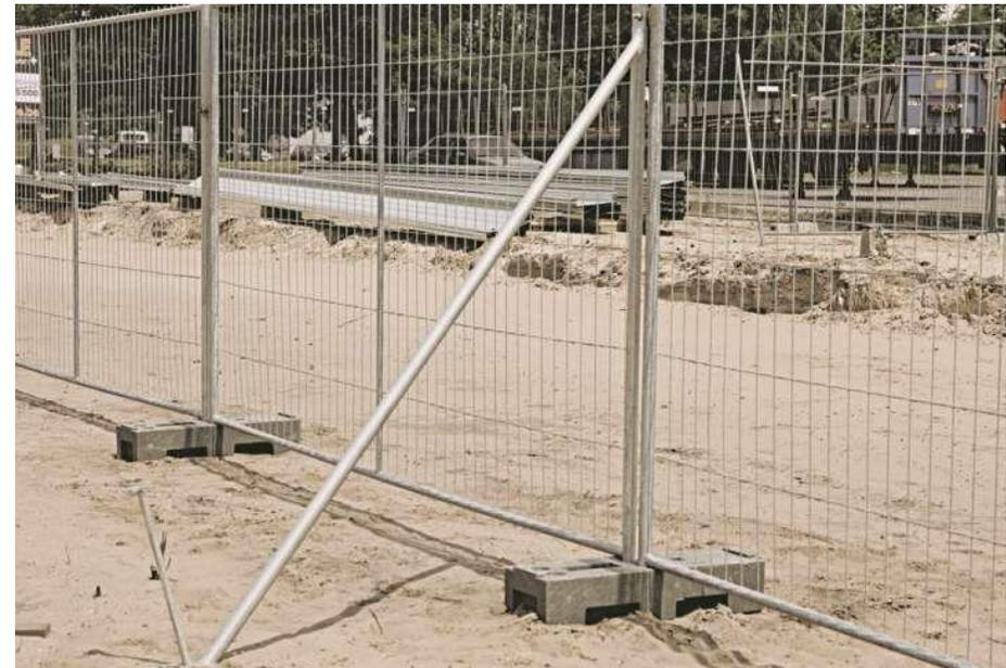
Figure 17 : Exemple de barrière de type HERAS (Source : HERAS)
