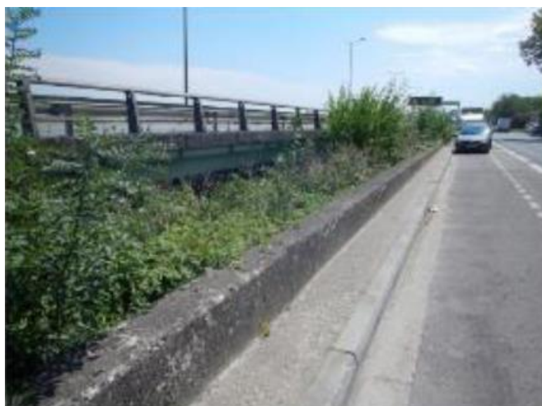
Figure 4: Photographies du muret de protection, source : prédiagnostic
