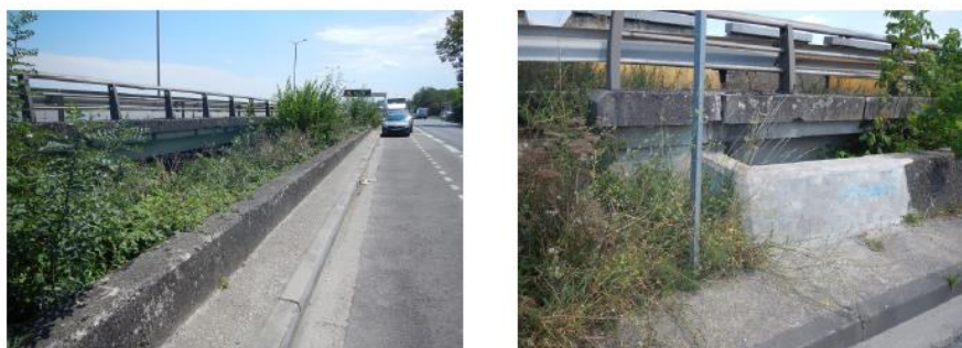
Figure 19 : Murets béton du tronçon 3
