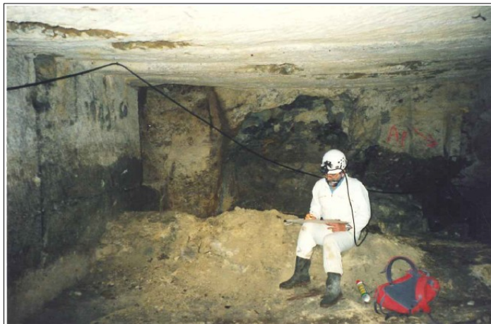
Vue de la carrière au droit du fontis de la parcelle AB4, on notera l'absence d'effondrement. Seules des traces de karst sont visibles au plafond (taches marrons). Les déboussages d'argile peuvent conduire à l'apparition de fontis, lorsque les conduits karstiques communiquent avec la surface.
