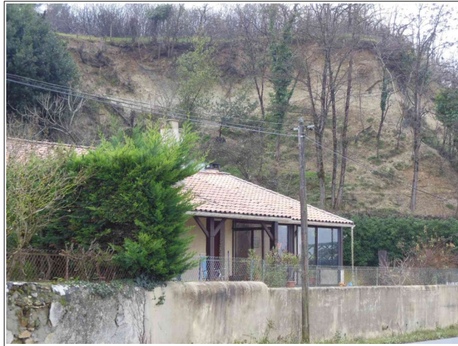
Rive droite de la Dordogne au lieu-dit La Tuilerie, le versant subvertical de la cote est le siège de mouvements de terrain récurrents qui atteignent la bordure de la RD18.
