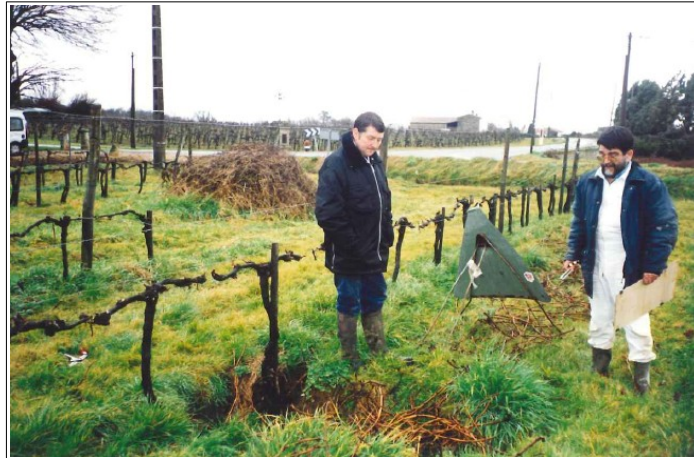
Vue du fontis survenu sur la parcelle cadastrée AB4.
