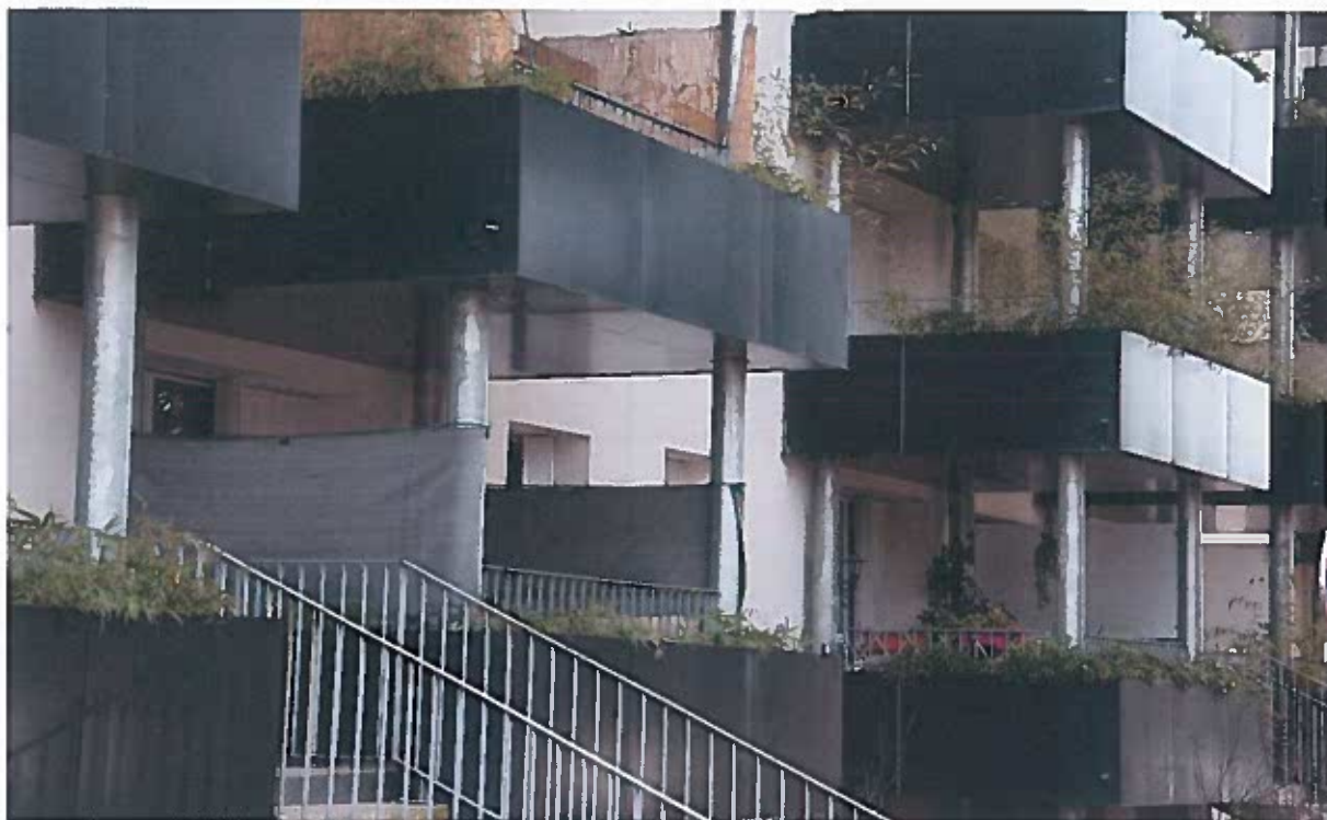
Balcons – Résidence ARAGO
