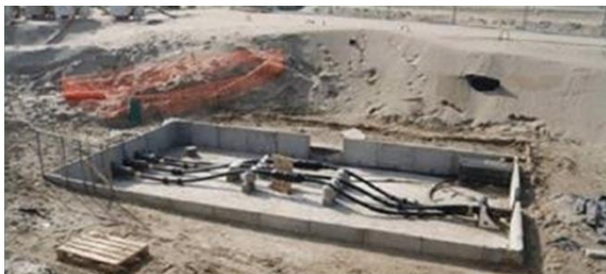
Chambre d'atterrage en cours de construction
