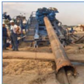
Forage dirigé Washover
