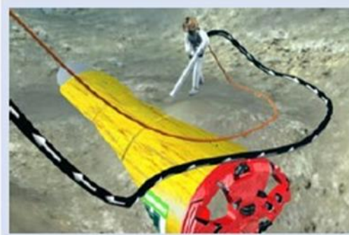
1.1 – Terrassement pour dégager le tunnelier
