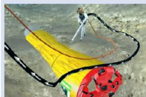
1.1 – Terrassement pour dégager le tunnelier
