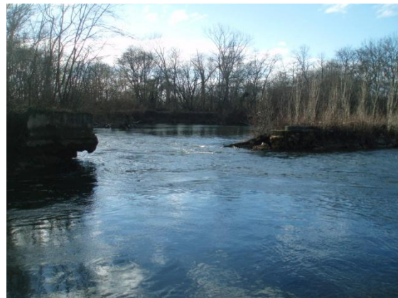
La retenue d'eau du moulin De Reyraud aux Eglisottes La digue est partiellement effondrée, permettant à nouveau l'écoulement normal des eaux
