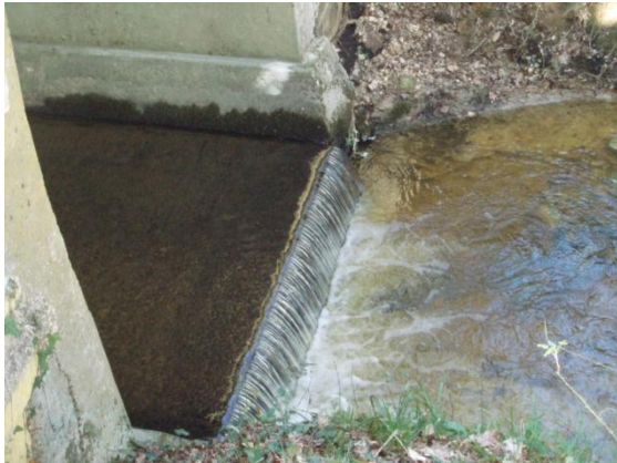
Deux exemples de dessous de pont à aménager pour permettre la remontée de la rivière par l'anguille (la Mozenne et la Mâme)
