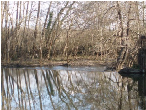
La retenue d'eau du moulin désaffecté des Herbeux à Saint Aigulin le saut d'eau est de 2 mètres de hauteur
