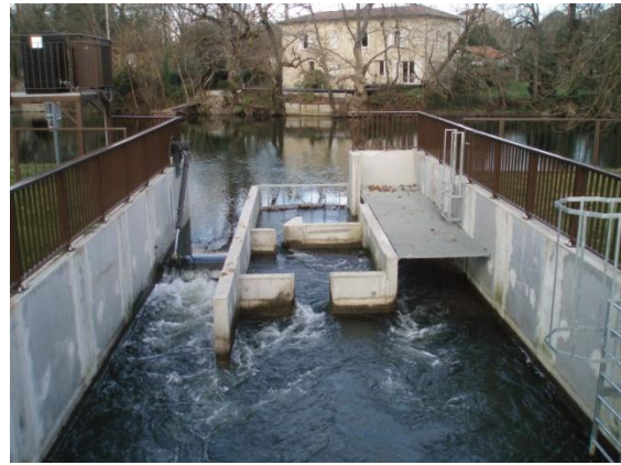
Dispositif de sortie amont de la rivière de contournement à COUTRAS
