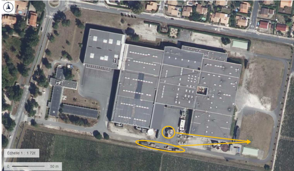
Vue aérienne actuelle avec localisation des stockages extérieurs à déplacer
